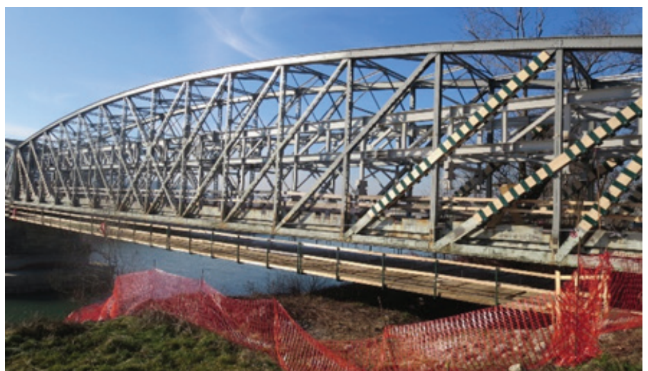
Slika 3 • Samonosilna začasna jeklena podporna konstrukcija znotraj obstoječe konstrukcije.
