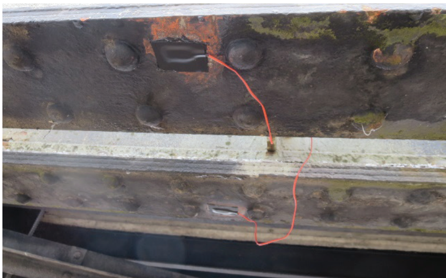
Slika 16 • Zaščiteni merilni lističi za meritev napetosti na spodnji strani spodnjega pasu.
