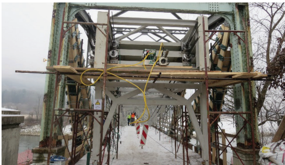
Slika 5 • Podpiranje podporne konstrukcije in sidranje kablov.
