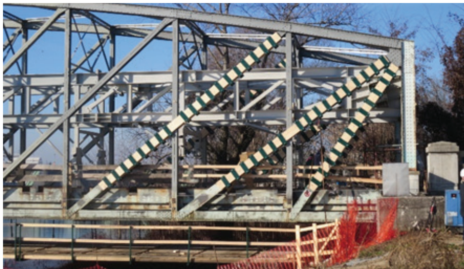
Slika 9 • Ojačitev nateznih diagonal (prvih treh) z lesom in jeklenimi sponami.
