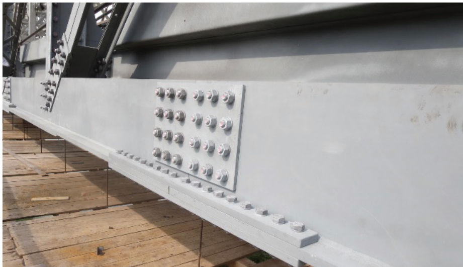
Slika 7 • Spodnji pas po zamenjavi.
