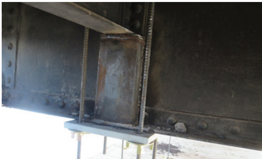
Slika 11 • Ojačitev vmesnih prečnikov na mestu obešanja.
