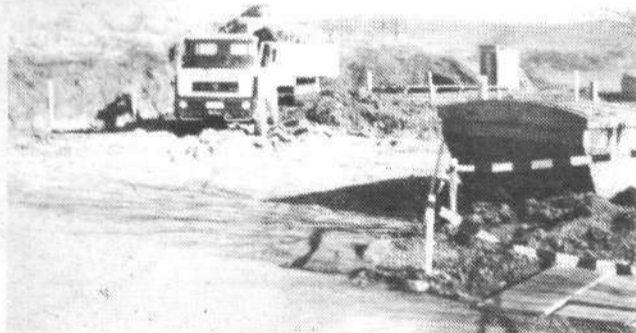
Gradbišče prizidka OŠ Dobova
