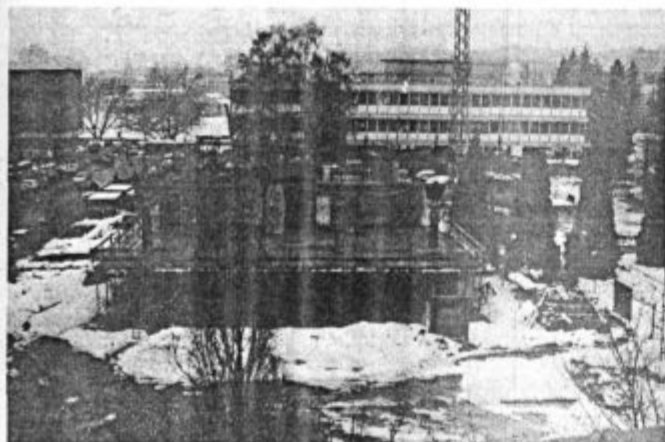
Prva novogradnja - poslovni objekt ob Rudarski cesti
