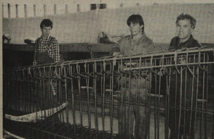
UJETI V MREŽO - V Obratu gradbenih polizdelkov pospešeno izdelujejo strešne nosilce za gradbišče Emone. Zvezati je treba kar precej armature in delavci zgledajo, kot ujeti v železno mrežo.
