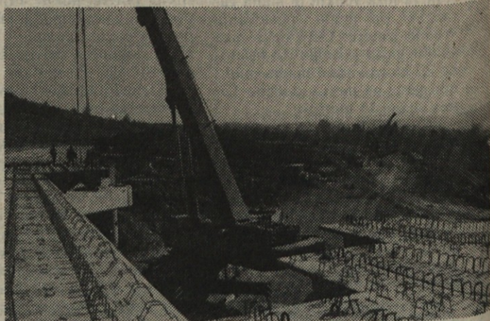
Ko so manjkali samo še trije elementi na podvozu pri Razdrtem, 300-tonsko avtodvigalo pomagalo tudi pri Razdrtem
