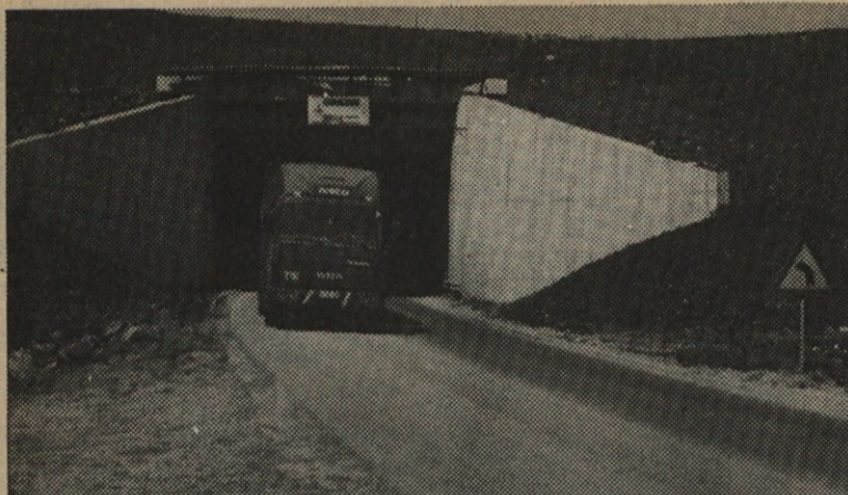
Največji podvoz pri Razdrtem je bil zgrajen že lani in skozi poteka promet proti Novi Gorici. Dolg je 64 metrov, visok pa 8 metrov.
