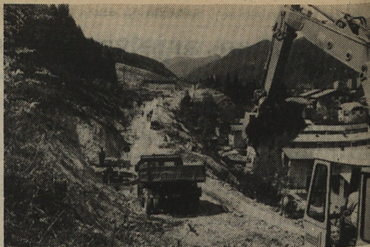
Viadukt 6-1 v gradnji, na trasi AC Hrušica - Vrba pod Mežaklo.
