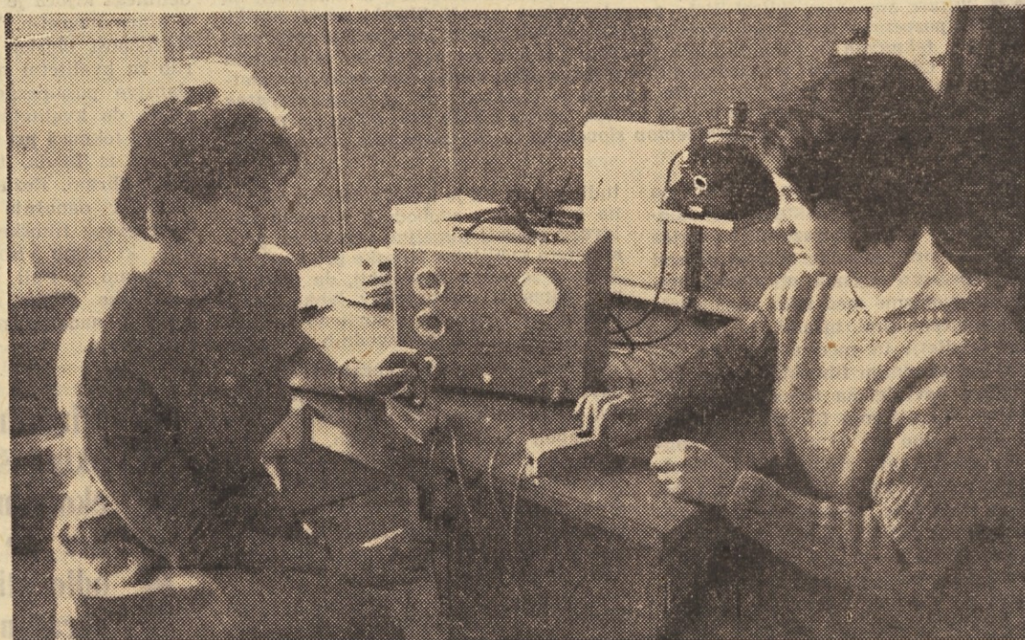
V ljubljanskem inštitutu fakultete za elektroniko in šibki tok so izdelali po načrtih inž. Arsenia Šurlana »merilnik reakcijskega časa. Z novo pomembno tehnično pridobitvijo se lahko točno izmeri čas regiranja, ki je pomemben pri voznikih motornih vozil, pri različnih drugih poklicnih dejavnostih, kjer odloča hitrost (gibanje rok), na primer pri stiskalnicah in drugod. Aparaturo bodo v marcu razstavili na razstavi izumov v Bruslju, za sedaj pa koristno služi športni ambulanti v Ljubljani, kjer z novim aparatom merijo refleks športnikov.
