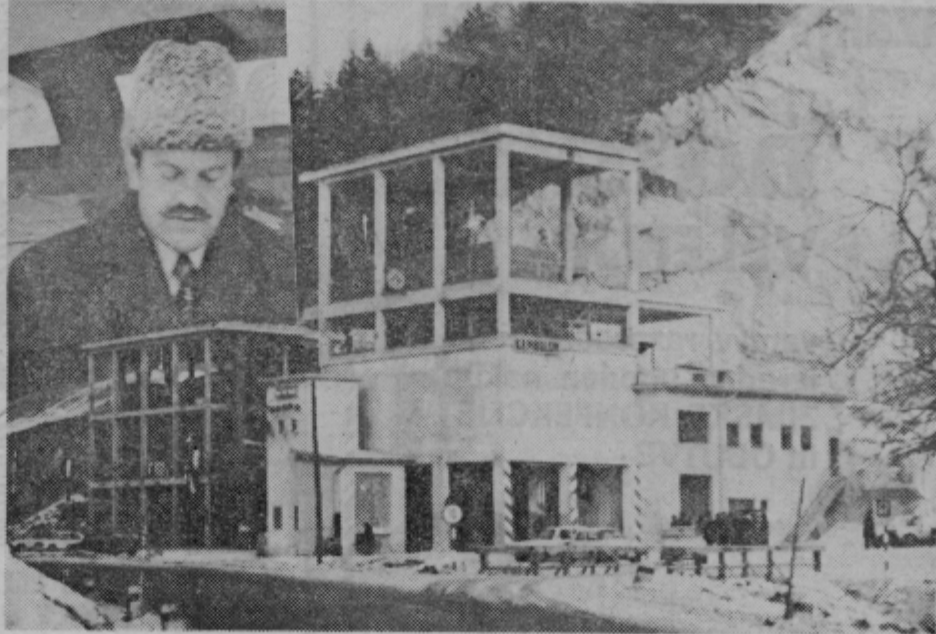
Pod okriljem celjskega cestnega podjetja je začel v Veliki Pirešici obratovati novi kamnolom. V levem gornjem vogalu: direktor Cestnega podjetja, Stane Divjak, ob otvoritvi novega objekta.
