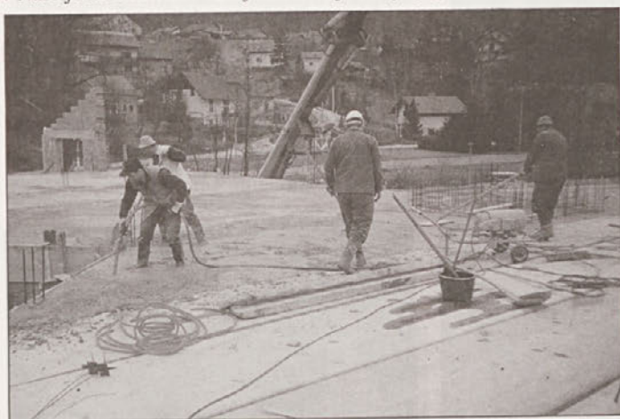
Delavci SGP Zasavje vlivajo drugo ploščo.
