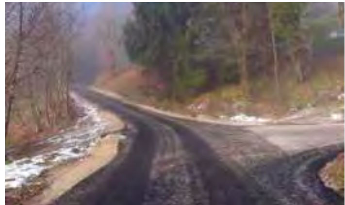
Obnova dela ceste Bršlenovica–Prvine.
