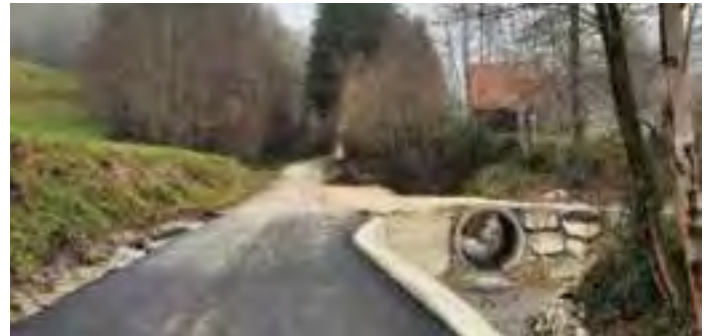
Sanacijska dela poškodovanega odseka lokalne ceste Spodnji Petelinjek–Javorje.
