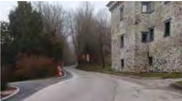
Izvedba mulde pri gradu Brdo.
