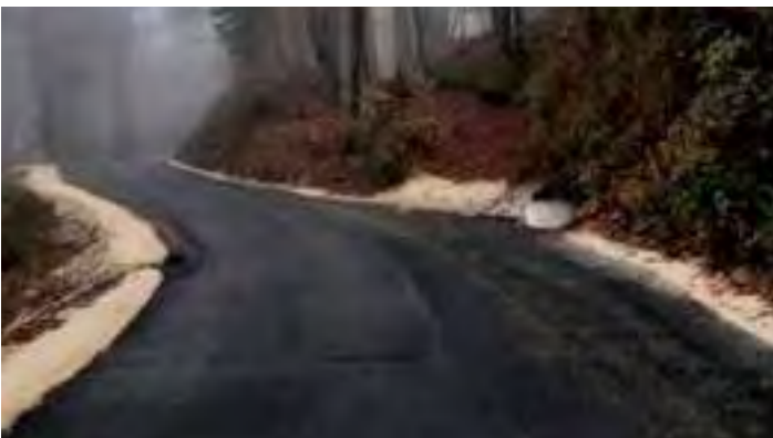
Prenova ceste na odseku Krajno Brdo.
