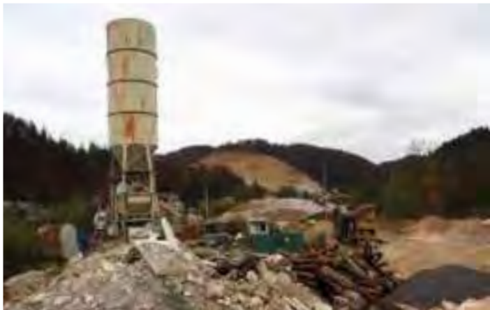
Separacija odpadnega in gradbenega materiala.
