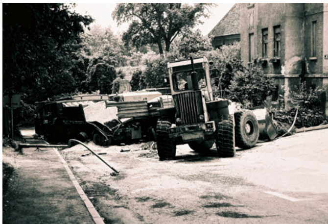
Slika 5: Poškodovan tovorni avtomobil Cestnega podjetja Ptuj, na katerega so vojaki JLA iz objestnosti izstrelili tankovsko granato (foto: Bojan Orešek, OKS UNZ Maribor)
