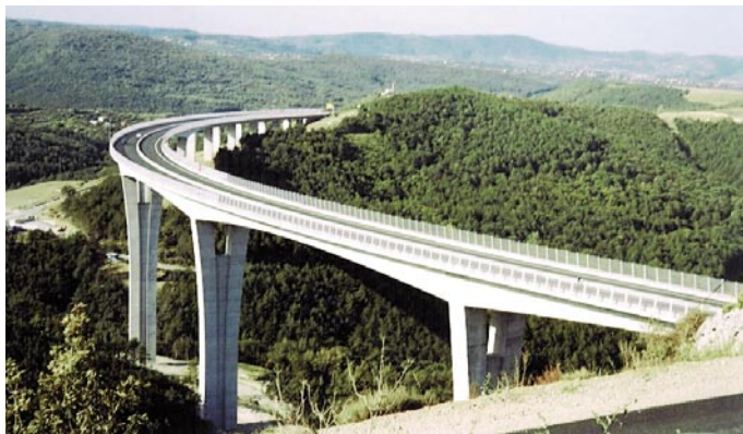
Slika 1 • Viadukt Črni Kal
