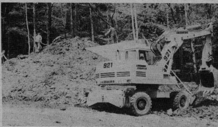
Dela na zakritju rezervoarja za vodovod na Gneču gredo h kraju
