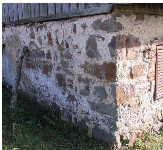
Slika 282: Kamniti zid hiše na Hribu, Vrhi. Levo od vogala je zazidana stara odprtina okna, velikosti približno 60x80 cm.
