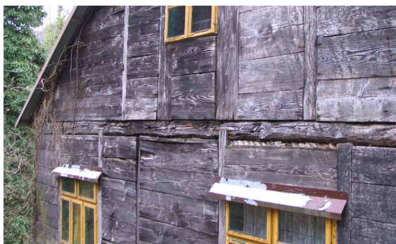
Slika 125: Konstrukcija v 20. stoletju predelanega in dodanega dela v ključ. Hrastov okvir in polnila iz smrekovih plohov.
