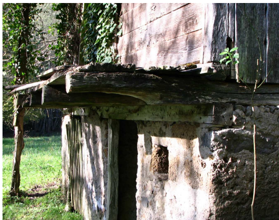
Slika 70: Kamniti zid kletnega dela z gankom: vrata brez zidane preklade ter edino okence v kleti.
