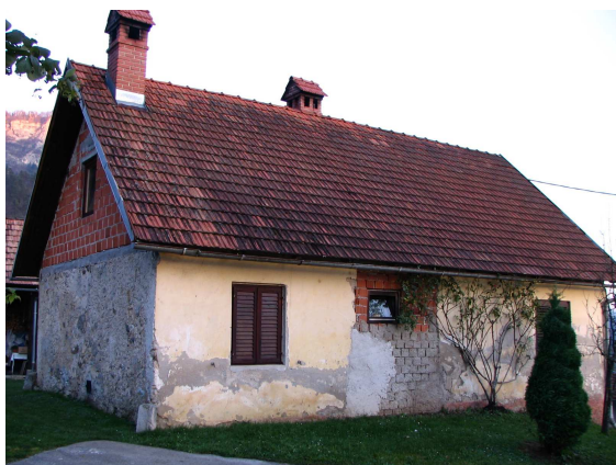
Slika 228: Nekdanja vhodna, zahodna fasada Grgečave hiše, obrnjena v smer Svete Gore in gornjega dela doline.
