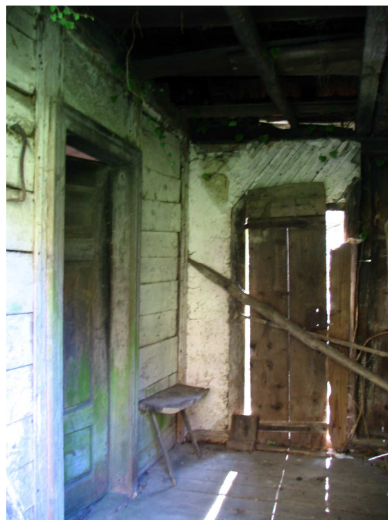
Slika 73: Veža z glavnega vhoda, levo vrata za hišo, desno kot za drva in spredaj vrata na gank. Levo od njih je viden del zidane stene, omet se vleče še nad vrati, kar nakazuje, da je bil to s hišo nekoč enoten prostor, brez pregradne stene.
