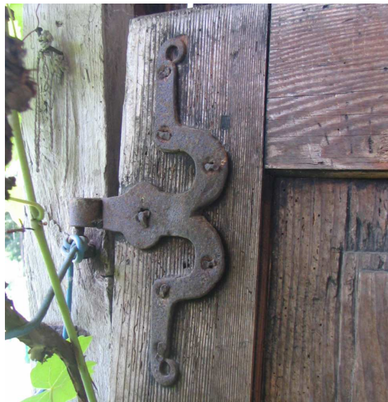
Slika 38: Stari vratni kovani tečaj, sicer skromno izdelanih kasetnih notranjih vrat, vsaj okov verjetno iz prve polovice 19. stoletja. Takih oblik v zgornjem delu kolpske doline ne poznamo.
