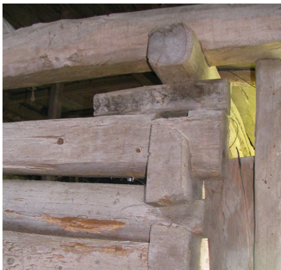
Slika 55: Spoj zgornjih brun ostenja poda z vžaganim ležiščem. V osrednji hrvaški temu spoju rečejo »horvatski vugel«.
