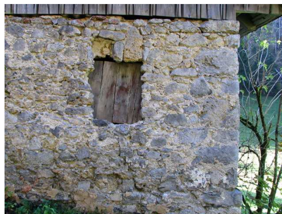
Slika 266: Pogled na kamniti zid in grobo izdelano okensko odprtino Pintarjave hiše v Križevi Dragi, nahaja se na zgornji strani hiše proti bregu in je manjša od tistih iz sredine 19. stoletja. Mere gradbene odprtine so pribl. 60x80cm
