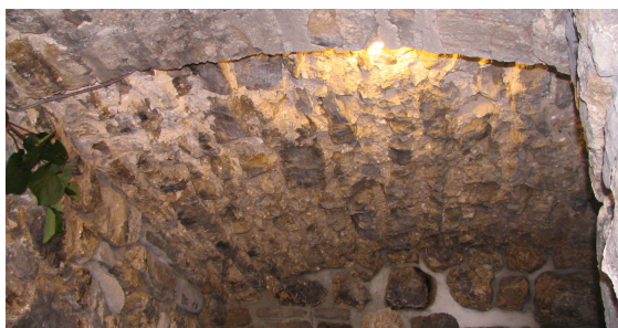
Slika 218: Plitvo, s kamenjem obokan strop na koncu kleti ni izdelan za večje obtežbe. A je ognjeodporen, primeren za okolico ognjišča.
