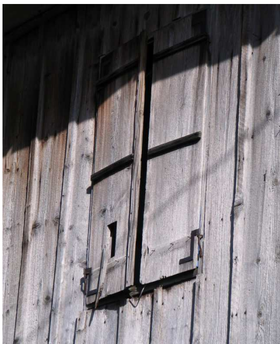
Slika 296: Polkno z izrezanim okencem za osvetljevanje fotografskih negativov na južni strani hiše.
