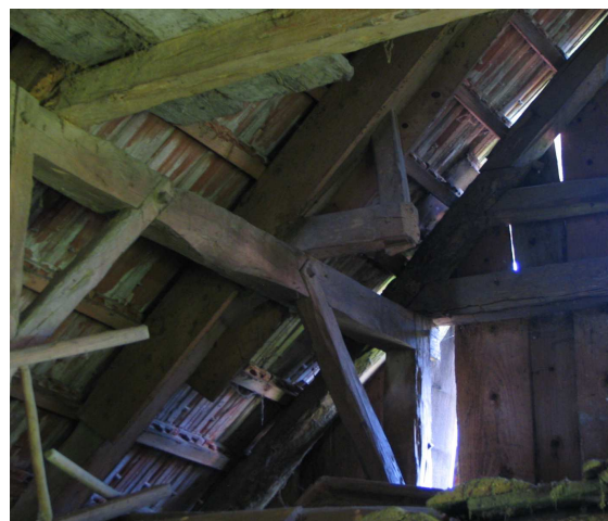
Slika 57: Konstrukcija ostrešja iz trdega lesa, z naležnimi rokami tam, kjer ni horizontalnih veznih gred, ki drugod podpirajo in razpirajo škarnike.
