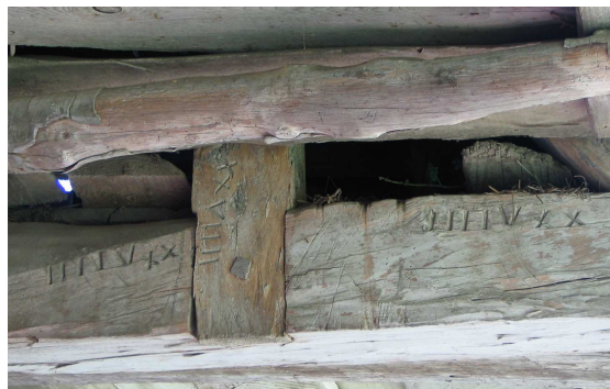
Slika 54: Detajl spoja konstrukcije ostrešja iz trdega lesa, grede in spoji nosilne konstrukcije so označeni z vrezanimi rimskimi številkami.
