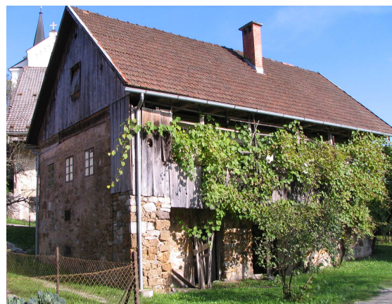
Slika 30: Pogled na Podliparsko hišo z zadnje, zahodne strani. Pod razraščeno trto je skrit gank, a brez stopnic. Vidno je od stropnikov dvignjeno ostrešje.
