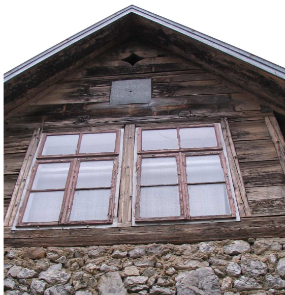
Slika 137: Lepo izvedena lesena frčada nad zidanim spodnjim delom hiše.
