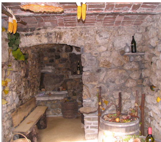
Slika 216: Vhodni prostor kleti v sredini Petričkave hiše, stari omet je odbit in stene očiščene.
