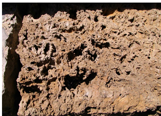
Slika 62: Struktura enega od vogalnikov Podliparske hiše iz peščeno rjavega lehnjaka izpod Nežice, Fara. Lehnjak je biokemična sedimentna kamnina, ki nastane, ko voda, ki vsebuje kalcijev karbonat teče čez organske ostanke (liste, veje) in se na njih izloča ter jih na ta način obda. Je močno porozna, lahka in luknjičava kamnina (Wikipedija).
