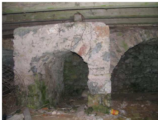
Slika 273: Masivna, široka in globoka baba Pintarjave hiše v Križevi Dragi. Na levo in desno sta krajša polkrožno obokana prostora, ki v sredini še dodatno opirata babo proti obodnim stenam objekta. Z zadnje strani njeni stabilnosti služi prečni obok kleti. Stropni tramovi so sekundarni.
