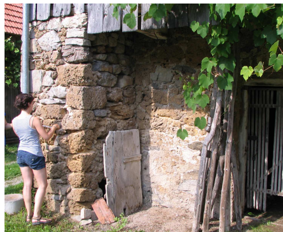
Slika 36: Na dvoriščni strani, na koncu ganka levo je sekundarno prizidana suha straniščna jama z vogalniki iz lehnjaka.
