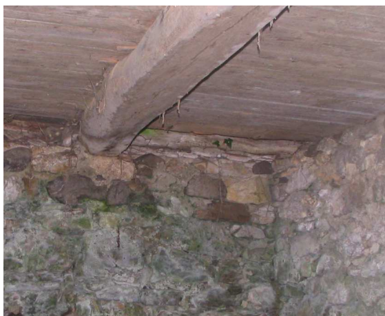
Slika 72: Struktura skromnega kamnitega zidu kletnega dela z notranje strani, zgoraj je vidna hrastova prečna greda.
