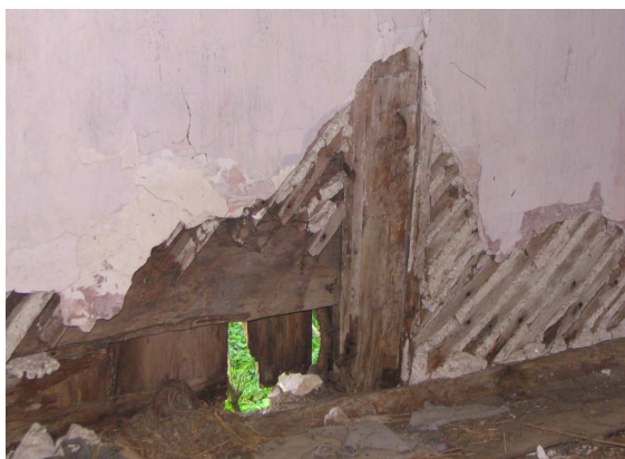
Slika 75: Konstrukcija zunanje stene z notranje strani. Nosilni vertikalni tramovi kasetne konstrukcije, polnilo so smrekovi plohi, zunaj zaščiteni s pribitimi vertikalnimi deskami, znotraj poletvani in ometani z apnenim ometom.
