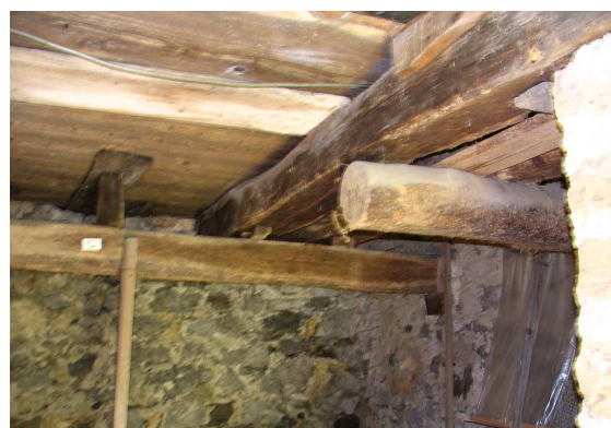
Slika 39: Delno porezani, sicer močni hrastovi tramovi v kleti, položeni preko babe (desno) kažejo, da je bila hiša nekoč temeljito predelana. Mogoče so bili 1857. leta požagani le njihovi pogoreli deli.
