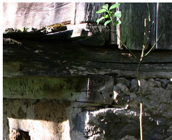
Slika 71: Bližnja slika konstrukcije v vogalu: povezni tram po dolžini zidu hiše levo, na katerega so položeni močni hrastovi prečniki. Na njih je postavljena kasetna konstrukcija nadstropja.
