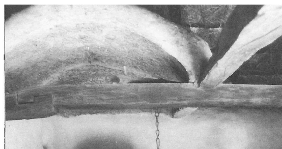
Slika 76: Tako nekako bi lahko izgledala konstrukcija velba nad ognjiščem za gašenje isker in odvod dima proti podstrešju, potrebna je bila tudi pri nizkem ognjišču. Fotografija iz literature.
