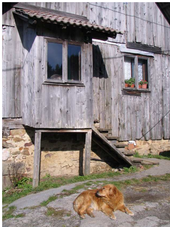
Slika 288: Vhod v hišo je predelan, dodan je bil mali vetrolov. Nekoč so šle lesene stopnice naravnost do vhodnih vrat. Tudi okna so drugačna od povojnih. Originalno so bila dimenzije pribl. 70x110cm.
