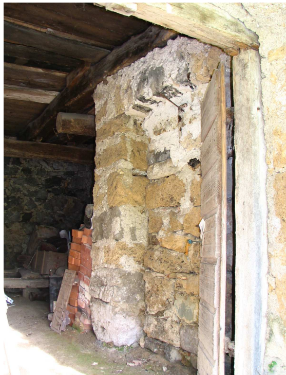
Slika 34: Pogled na plitvo obokano baba iz zunanje strani. Kasneje je bila podzidana zaradi dimnika, ki ga mora nositi.
