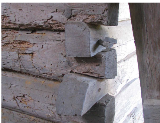
Slika 56: Spoj brun na lastavičji rep. Repi niso poravnani kot pri hišah, saj gre za zgolj funkcionalno konstrukcijo. V osrednji hrvaški je ta spoj poimenovan »nemški vugel«.
