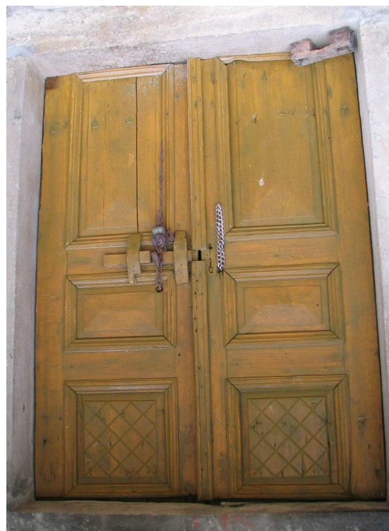
Slika 198: Malce obrezana, v kletni vhod sekundarno vgrajena nekdanja prva vrata v hišo Zajskih, povojni izdelek. Fotografija je obrnjena na glavo, ker so vrata vgrajena ravno obratno kot so bila prvotno.
