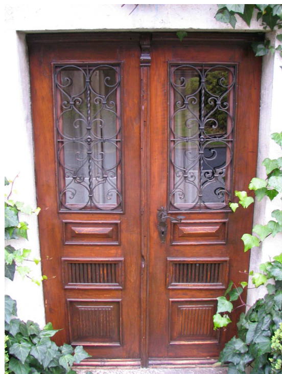
Slika 140: Lepo obnovljena vrata pri Navrtnih; vrata so iz konca 19. ali začetka 20. stoletja.
