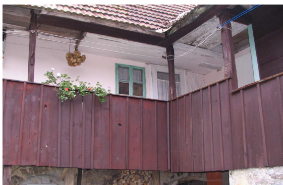
Slika 97: Srednji del ganka na prelomu med hišo in delom v ključ. Leva stena zidana in ometana zaradi peči in ognjišča, desni del je lesen.
