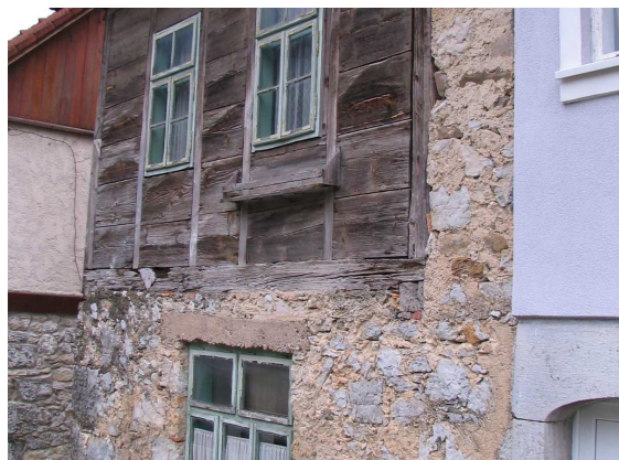
Slika 138: Kombinacija kamnite in lesene dogradnje iz konca 19. stoletja na kamniti osnovi iz začetka 19. stoletja, pri dvolastniški stavbi v 1970-ih.
