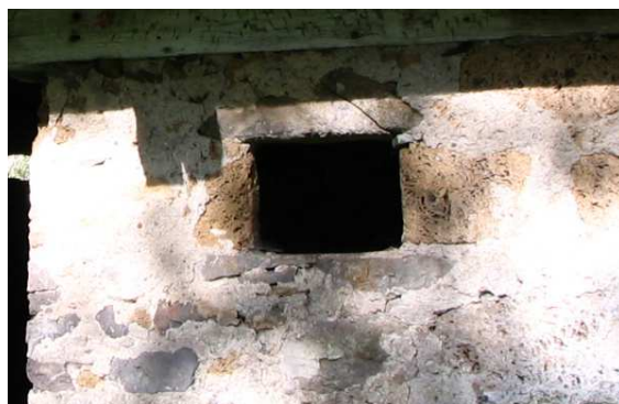
Slika 80: Reprezentančni okvir kletnega okenca izveden s kosi lehnjaka, hišica na Ločici pri Fari. Iz lehnjaka je le še nekaj zgornjih vogalnikov desno, ki so na vsej hišici najbolj vidni.
