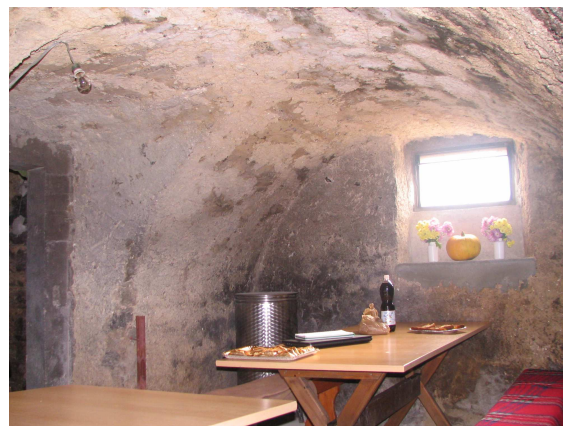
Slika 222: Pogled proti oknu, ki je bilo prvotno manjše, v polkrožno obokanem prostoru kleti Petričkave hiše. Sumljiva so vrata levo, proti osrednjemu delu kleti, saj bi bila lahko prebita kasneje, čeprav so kamniti bloki po vogalih lepo obdelani. Žal kasnejši omet pokriva sledove morebitnih predelav.
