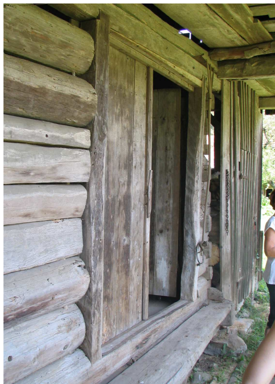
Slika 52: S sorniki spojeni končni deli brun poda proti okviru vrat, vidni levo od vrat zgoraj. Tla poda so lesena iz debelih plohov položenih na hrastove grede, ki ležijo na velikih temeljnih kamnih peščenjaka iz Kolpe.
