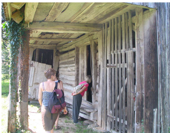
Slika 51: Skedenj s sprednje, cestne strani in pod nadstreškom - zvozom, desno je pod z brunastim ostenjem. Spredaj (desno) drvarnica, prej stevenca in zadaj šuta .
