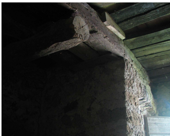
Slika 33: Desno - zidana in plitvo obokana baba , ki podpira široki in močni hrastovi gredi prečno čez stavbo. Nelogično prerezan vzdolžni podporni tram v ospredju kaže na kasnejše predelave.
