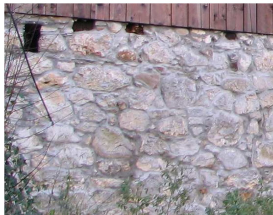
Slika 241: Kamnita struktura kletnega zidu Klukavčeve hiše na severo-zahodnem delu. Viden je poravnani pas proti vrhu, ki nakazuje ležišče nakdanjih prečnih tramov, kot je levi.
