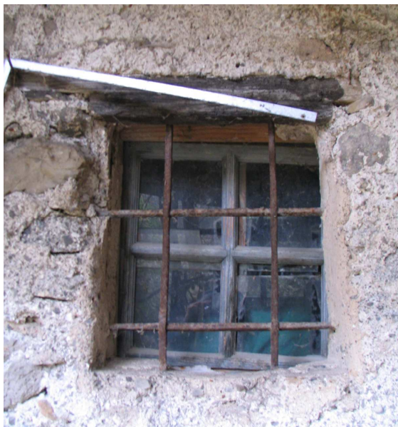
Slika 130: Zamreženo okence iz konca 19. ali začetka 20. stoletja, s hrastovo preklado, tako je levo in desno od vrat v štal. Široki razmak gajter kaže, da so bila nekoč na večjem oknu.
