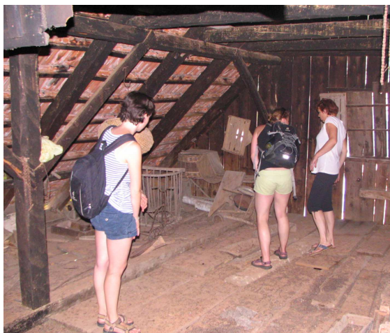
Slika 64: Raziskovanje visokega ostrešja in podstrehe Podliparske hiše, poleti 2014. Na podstrehi je ostalo le sušilo za sušenje mesa, sledov lesene kašče pa ni več.
