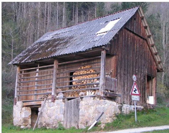
Slika 253: Skedenj Klukavčave domačije v Črnem Potoku, desni del kleti skednja stoji na zidovih nekdanje stanovanjske hiše iz začetka 19. stoletja ali prej. Pogled od kletnega vhoda hiše.
