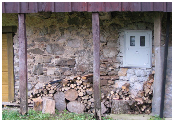
Slika 92: Kamniti del pod stanovanjsko etažo, levo novejša vrata iz 1908. leta v kujdr , ki je bil pod hišo, levo in nad omarico za električni priključek je še vidna stara in že dolgo zazidana, polkrožno obokana odprtina.
