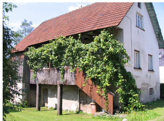
Slika 11: Značilna vrhhlevna, na strani hiše enotraktna stavba z gankom na južni, sončni strani, ki je poleti zasenčena s trto. Fara.
