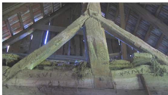
Slika 53: Podpore vertikalnega nosilca leg iz trdega lesa, grede so oštevilčene.
