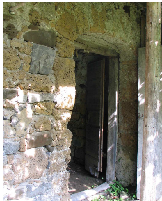
Slika 31: Elipsasto obokana preklada nad vhodom v klet, z zadnje strani pod gankom, še iz časa prve gradnje izpred 1824. Vidna je uporaba lehnjaka na delih, ki niso blizu talne vlage.
