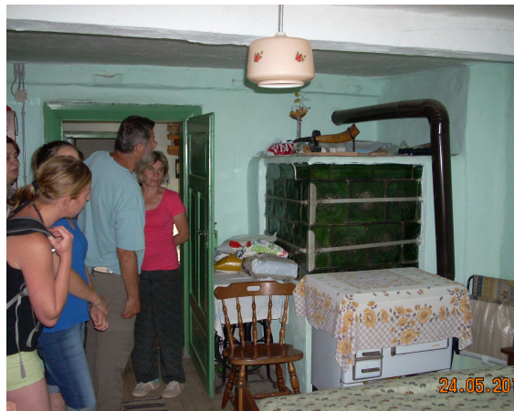
Slika 100: Krušna peč v hiši. Strop je sedaj poletvan in ometan, prav tako stropni prečni tramovi, ki so zakriti. Enako velja za srednji, običajno okrasni tram. Desno za pečjo je stena kamnita in zidana.
