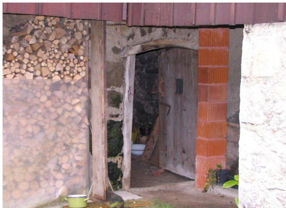
Slika 96: Vhod v hlev pod nadstreškom, ki ga ustvarja del a ključ. Skromen hrastov okvir širokega vratnega krila, skrbno napete oblike, tesane po obliki oboka preklade.
