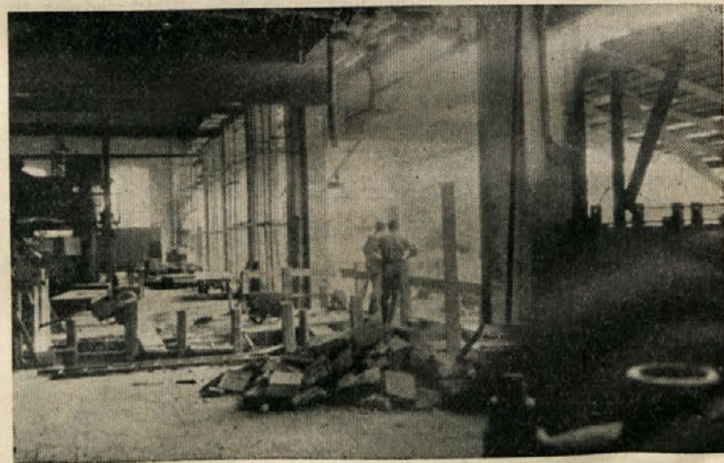
Stara zunanja stena je padla. Zdaj bodo začeli zidati novo, ki bo za pet metrov razširila obrat
