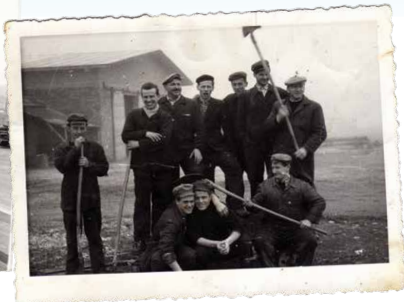
Udarniška gradnja vodovoda za KIG. Zgoraj: Franc Kramar, Martin Modic, Ivan Mehle, Stane Štrukelj, Anton Modic, Tone Inthar, spodaj: Jože Erjavec, Franc Božnar, Domine Majnik, 1958.
