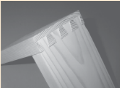
□ Slika 4. Strojno izdelani polkriti roglji - z ročnim rezkalnikom in šablono
