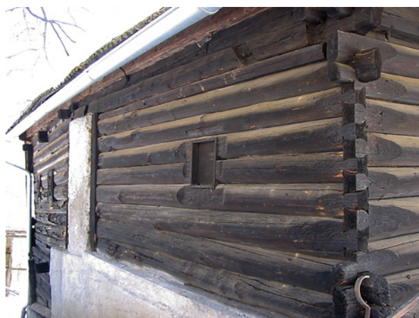
Slika 2. Kladne stene iz brun se na vogalih povezujejo z utori lastovičjega repa (foto: Vito Hazler, 19. 1. 2006).
