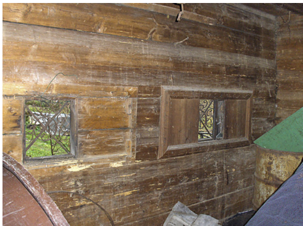
Slika 3. V najimenitnejšem prostoru Bedenikove zidanice, v t. i. salonu, so še ohranjena okna »na smuk« (foto: Vito Hazler, 8. 12. 2006).
