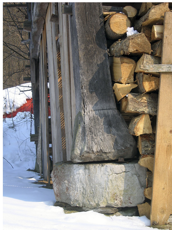
Slika 1. Steber kozolca je postavljen na kamen. S tem so učinkovito preprečili navlaževanje lesa iz tal. (foto: M. Humar)
