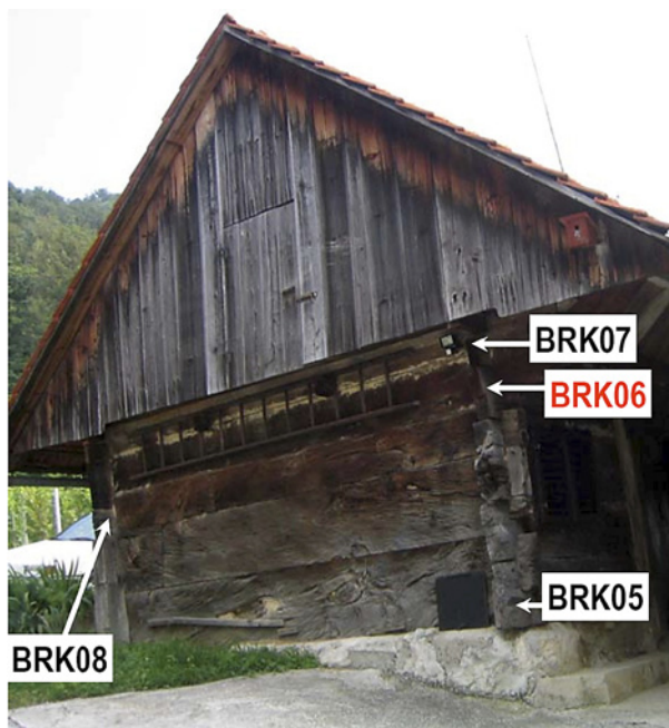
Slika 1. Berkovičev hram in delovne številke brun, iz katerih smo odvzeli izvrtke za dendrokronološko datiranje. Bruno BRK06 je imelo na delu na vhodnimi vrati vrezano letnico 1722 (Foto: K. Čufar 4. 8. 2004).
