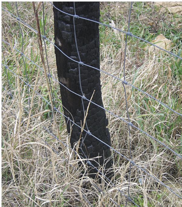
Slika 5. Obžgan spodnji del stebra ograje (foto: M. Humar).
