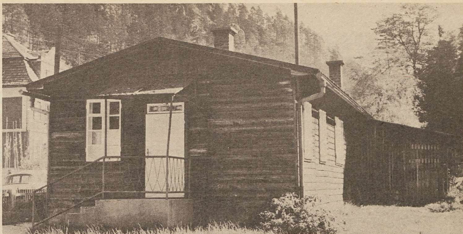
Vrtec „Žerjav“ se komaj lahko imenuje vrtec. Otroci imajo sicer streho nad glavo in tudi varstvo, vendar pa je vrtec stara, nekoč stanovanjska baraka.
