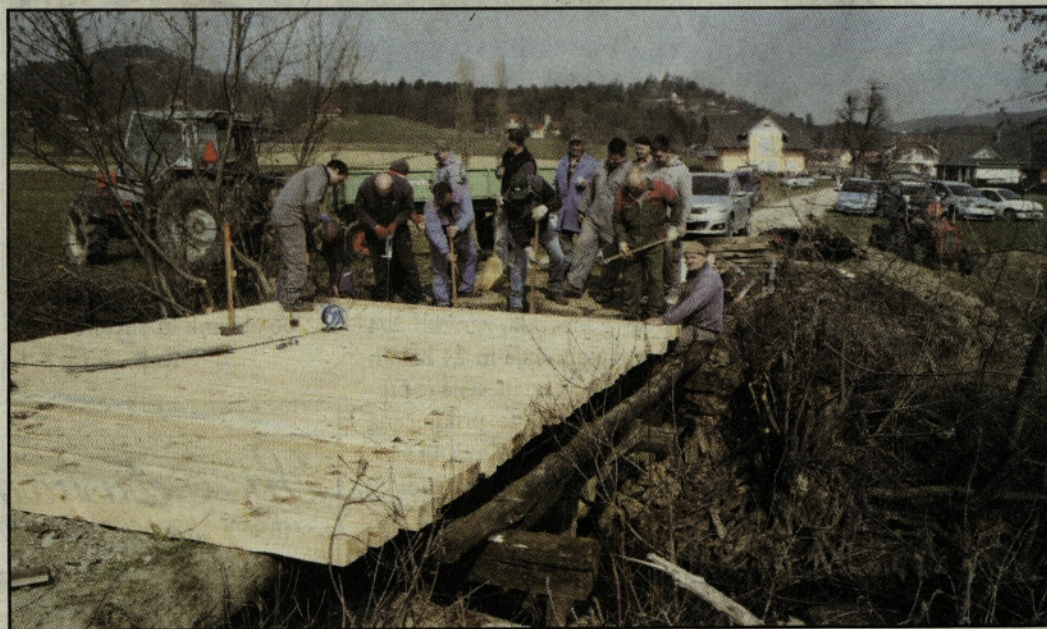
Prostovoljci med obnovo mostu
