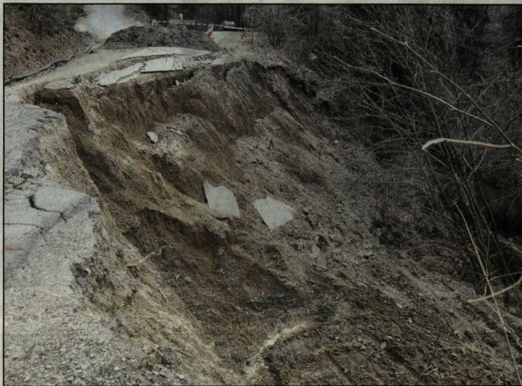
Sanacija plazišča bo draga, saj bo potrebno najprej utrditi teren.
