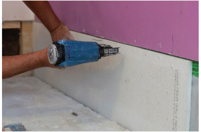
Slika 10. Pritrjevanje stenske obloge, september 2023.
