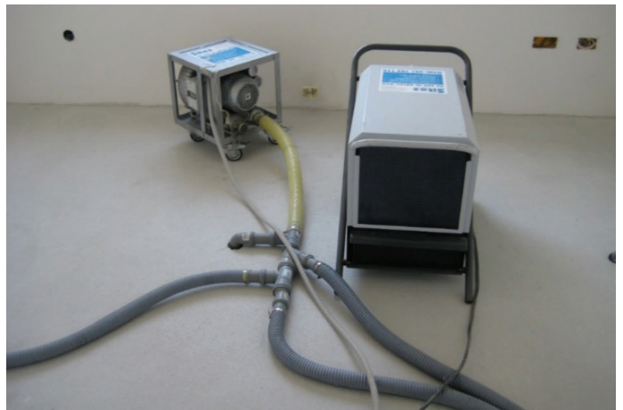
Slika 12. Izsuševanje estriha s turbinsko-kondenzacijsko metodo, avgust 2023.
