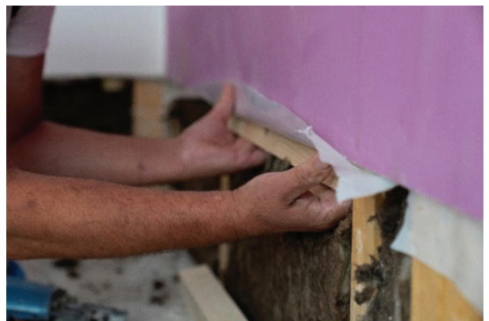
Slika 8. Nameščanje prečnikov za kasnejše pritrdjevanje stenske obloge, september 2023.
