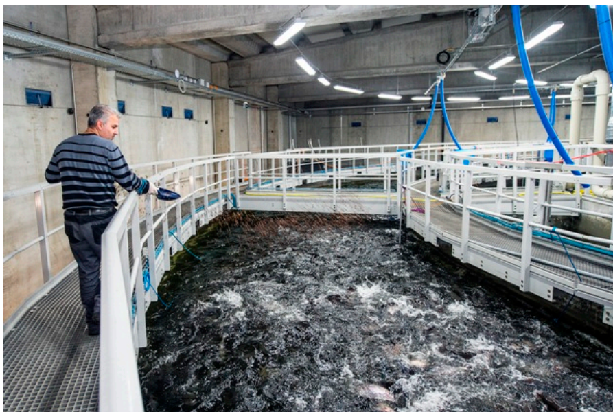
Slika 6: Velik okrogel bazen (globina 6 m, premer 32,5 m) kot del RAS za gojenje lososov ( Swiss Alpine Fish )
