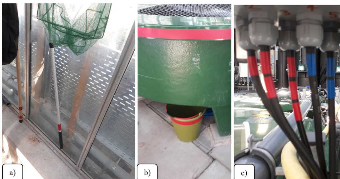
Slika 4: Sistem barvnega označevanja, ki preprečuje navzkrižno onesnaženje na ZHAW (foto: Andrej Ovca)
