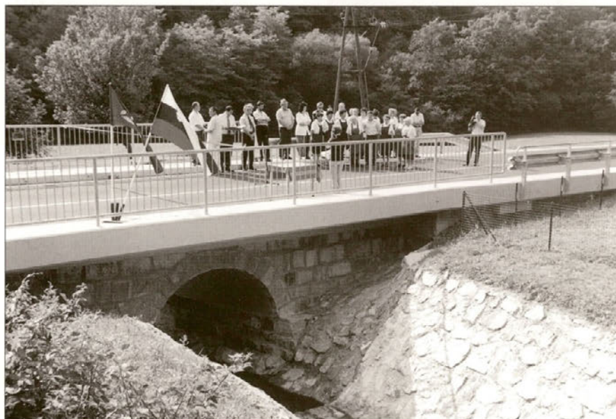
Domačini so se zbrali na novozgrajenem mostu. Te pridobitve so bili izredno veseli.
