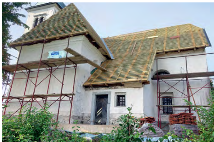
Že pokrita nova streha tik pred začetkom zaključnih del. Nova streha bo imela tudi žlebove, ki bodo učinkovito odvajali vodo in prispevali k osušitvi vlažnih zidov. (foto: Robert Brus)
