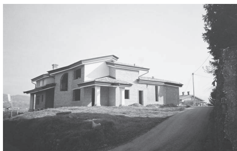
Slike 4, 4a, 4b: Novo ni oblikovano in zgrajeno z upoštevanjem identitete obstoječih grajenih
