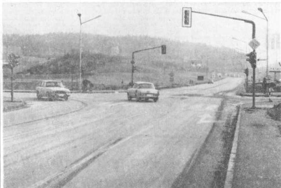
Na glavnem križišču v Velenju, ki povezuje cesto Celje—Soštanj s Slovenj Gradcem, je bilo zelo veliko nesreč. Zato so ga pred časom opremili s semaforji. Zal pa le-ti ob največjih prometnih konicah velikokrat ne delujejo. Za voznike motornih vozil, ki ne veste, pa še naslednje opozorilo: po novem je prednostna cesta Soštanj—Celje!
