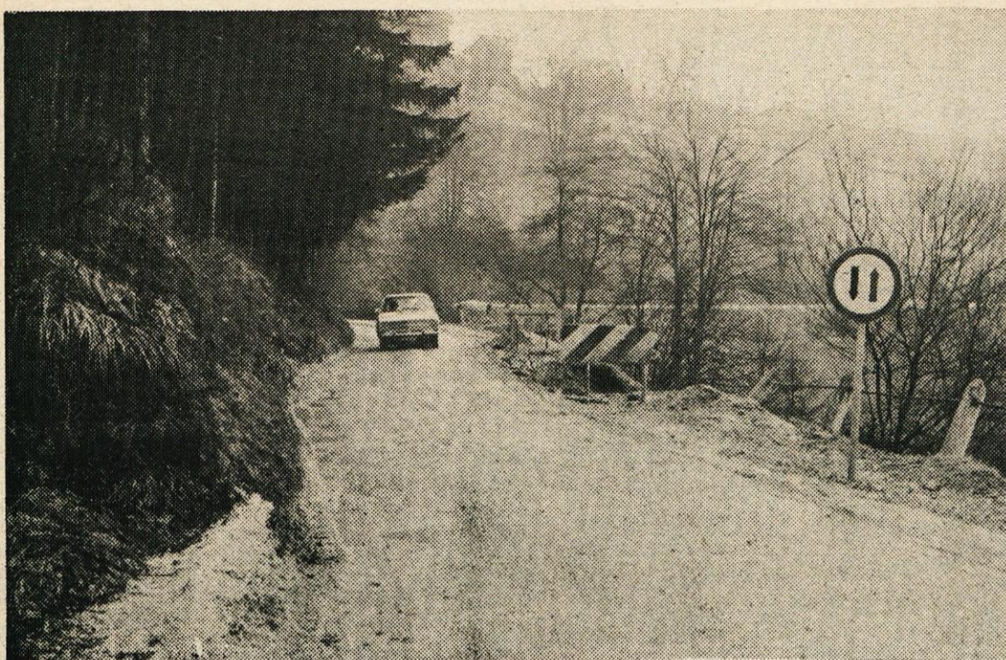
Na cesti od Bogenšperka proti odcepu za Javorje je plaz načel cesto. Nevarnost je izredno velika, na to so že večkrat opozorili tudi tamkajšnji domačini. (Foto: GO)
