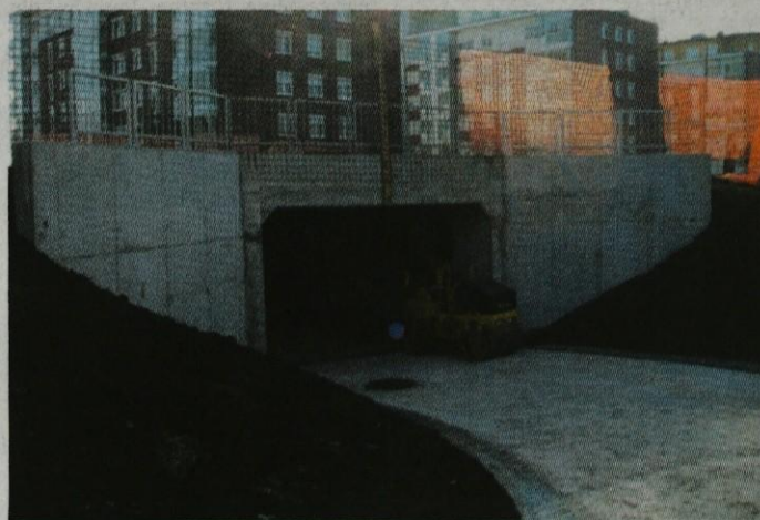
Nadaljuje pa se tudi gradnja podhoda pod nekdanjo magistralno cesto M-10. Če bo vreme, bo v kratkem podhod končan.
