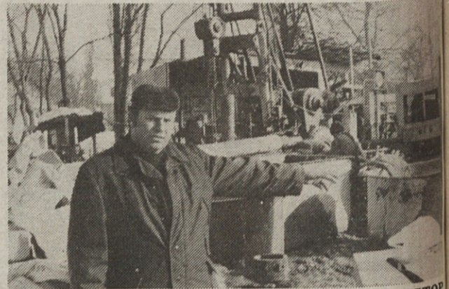
Prišli smo že do globine 260 metrov, delamo NON-STOP podnevi in ponoči, tudi če je 15 stopinj pod ničlo, je dejal vodja delovišča v Čatežu Ladislav Štih, do maja bomo privrtali do 1.000 metrov globoko.
