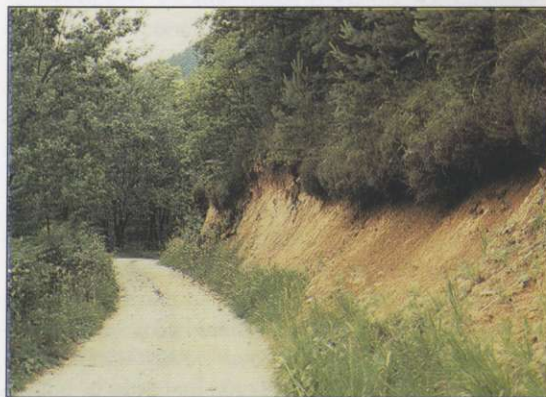
Slika 2: Cesta, ki povezuje raztresene domačije na severni strani jezera, poteka tik nad jezerom. (Foto: M. Vogrin.)
