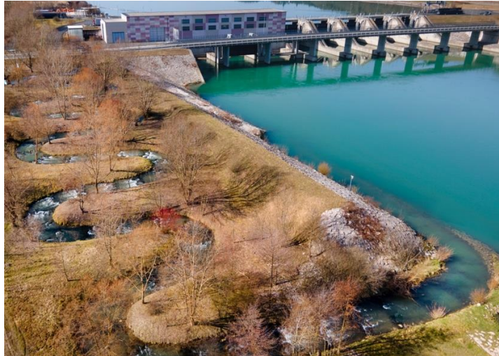
Slika 1: Primer hidroelektrarne Arto-Blanca s prehodom za ribe (Foto: S. Jeršič)
