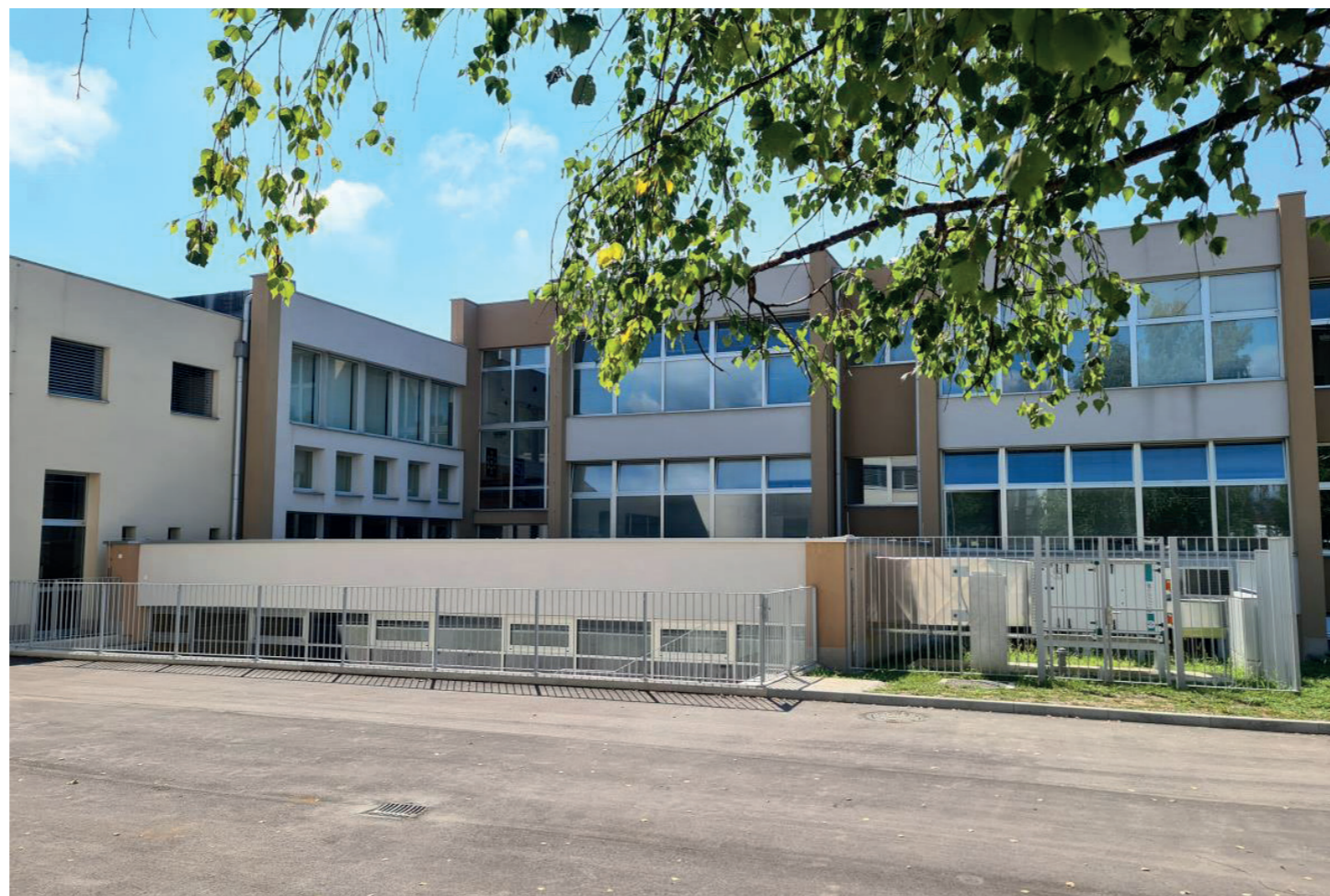
Dokončan prizidek jedilnice, septembra 2021 (povzeto po domzalec.si).
