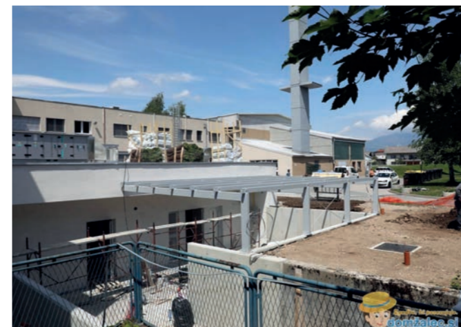
Gradnja nove kuhinje na vzhodni strani šolske stavbe (povzeto po domzalec.si).
