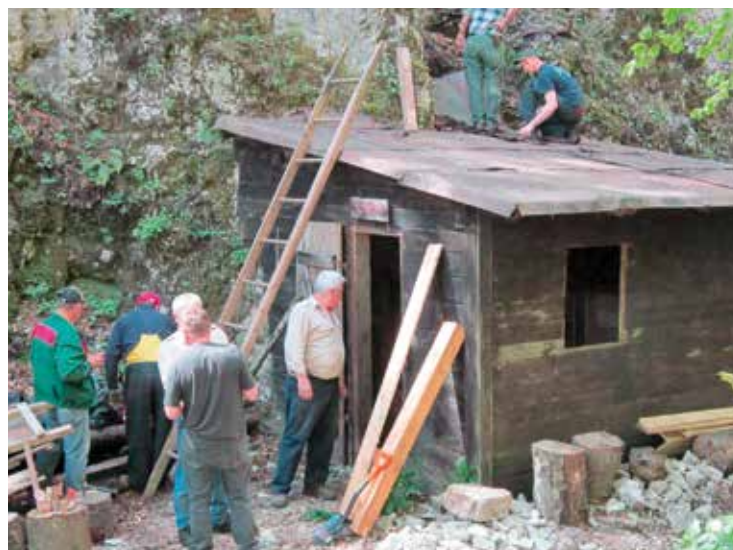
Obnovitvena dela na objektih
