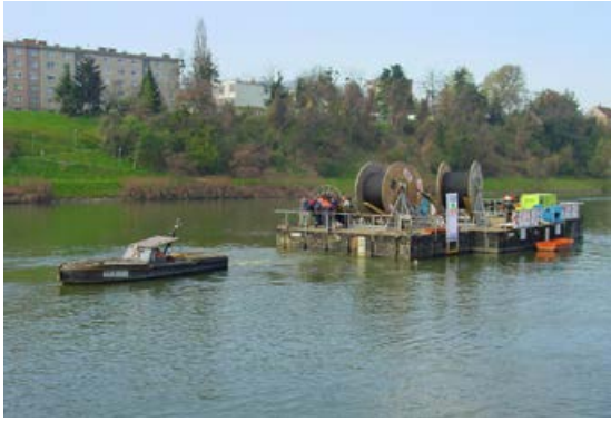
Slika 75: Polaganje kablovoda na dno Drave, arhiv družbe Elektro Maribor
