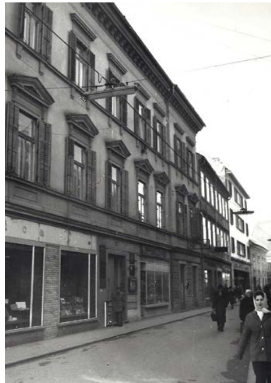
Slika 20: Sedež Elektriškega podjetja Maribor do leta 1928 na Jurčičevi ulici 8 v Mariboru, 1961, arhiv Pokrajinskega arhiva Maribor
