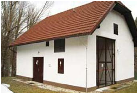
Slika 112: Mala hidroelektrarna Činžat I, arhiv OVEN Elektro Maribor
