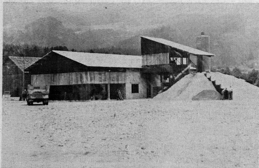
Nova betonarna je pomembna pridobitev za območje mozirske občine
