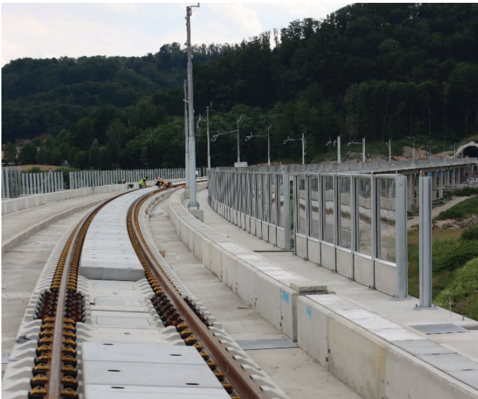
Slika 9. Prva aplikacija tira na togi podlagi na viaduktu v Sloveniji (foto: Ponting, d. o. o.).
