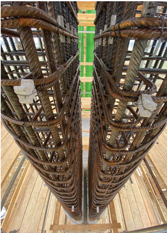
Slika 2. Kompleksna armatura razdeljenega stebra (foto: Srečko Prša, Pomgrad, d. d.).
