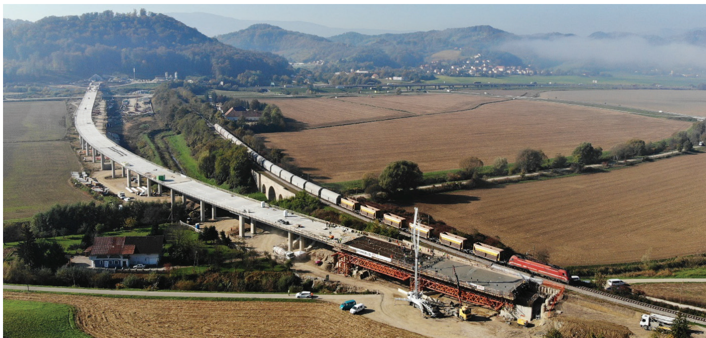
Slika 6. Betoniranje zadnjega segmenta, oktober 2022 (foto: Pomgrad, d. d.).
