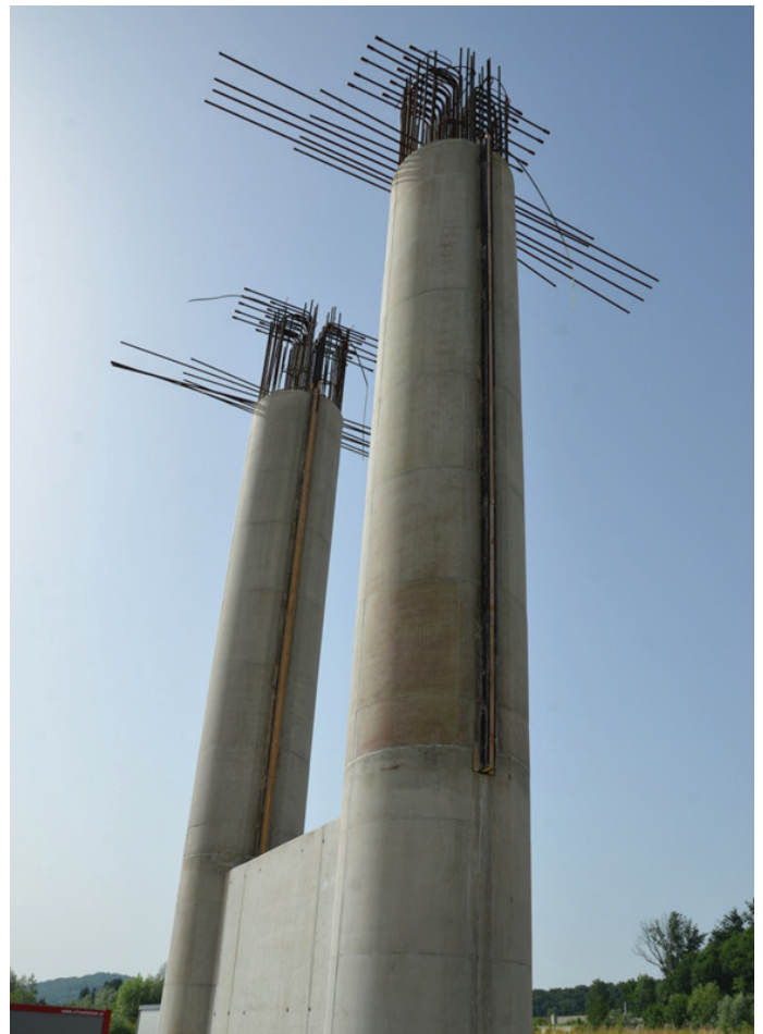
Slika 3. Razdeljeni steber je podpora dveh okvirjev (foto: Ponting, d. o. o.).
