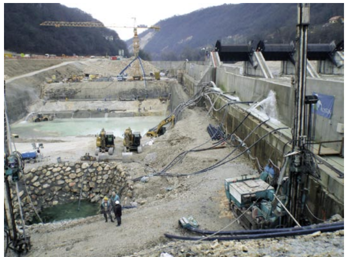
Slika 7 • Druga gradbena jama HE Krško, izvedba izkopov za strojnico; v ozadju levo – betoniranje prvih temeljnih blokov in izvedba drenažnih betonov, desno – zaščitni vodnjaški zid z ureditvijo odvodnjavanja, v ospredju levo – drenažno črpališče; stanje na 9. december 2009
