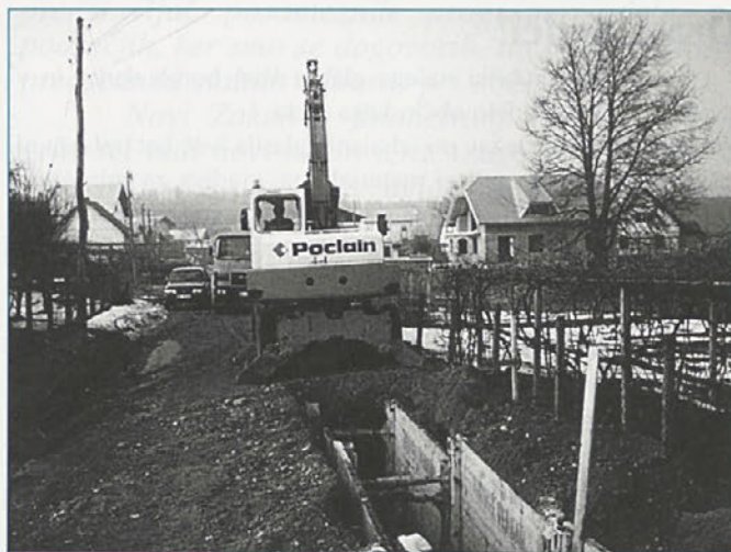
Gradnja kanalizacije v Njivercah
