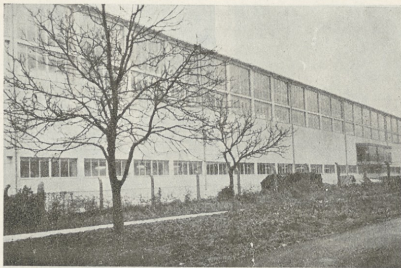
Papirnica Količevo — Zgradba kartonskega stroja II
