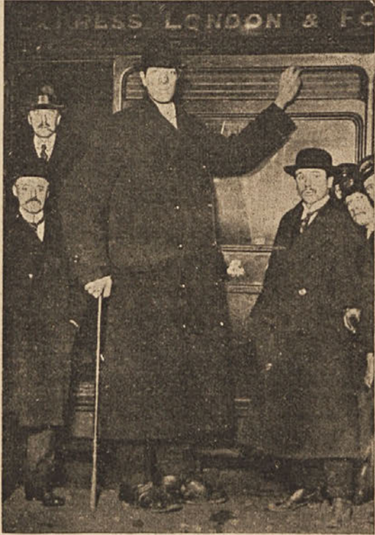
Največji mož na Angleškem: Friderik Dempster.
