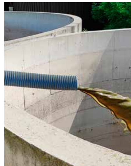
Tekoči del separirane gnojevke lahko skladiščimo tako, da ga vračamo nazaj v kanal (levo) ali pa skladiščimo ločeno (desno).
