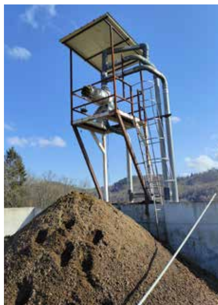
Separacija gnojevke in skladiščenje separata na prostem. Podlaga je betonska.
