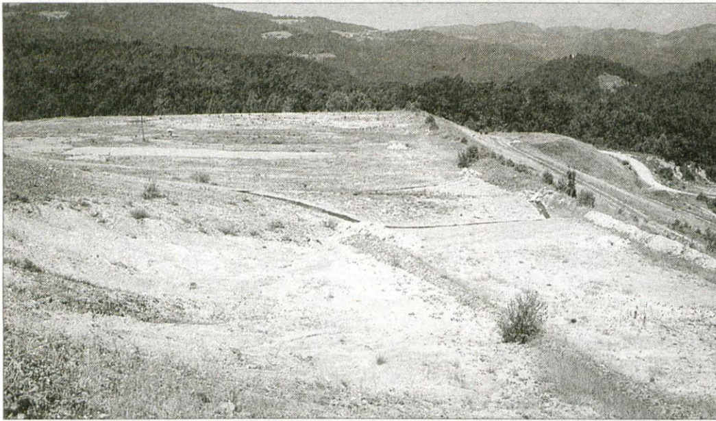
Jalovišče Boršt ponuja resnično žalostno sliko: odkrito jalovino izpira voda in raznaša veter.
