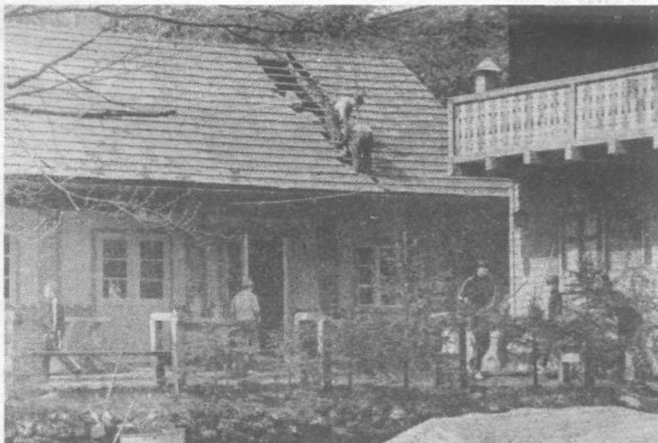
Popravilo doma pred skorajšnjim rušenjem
