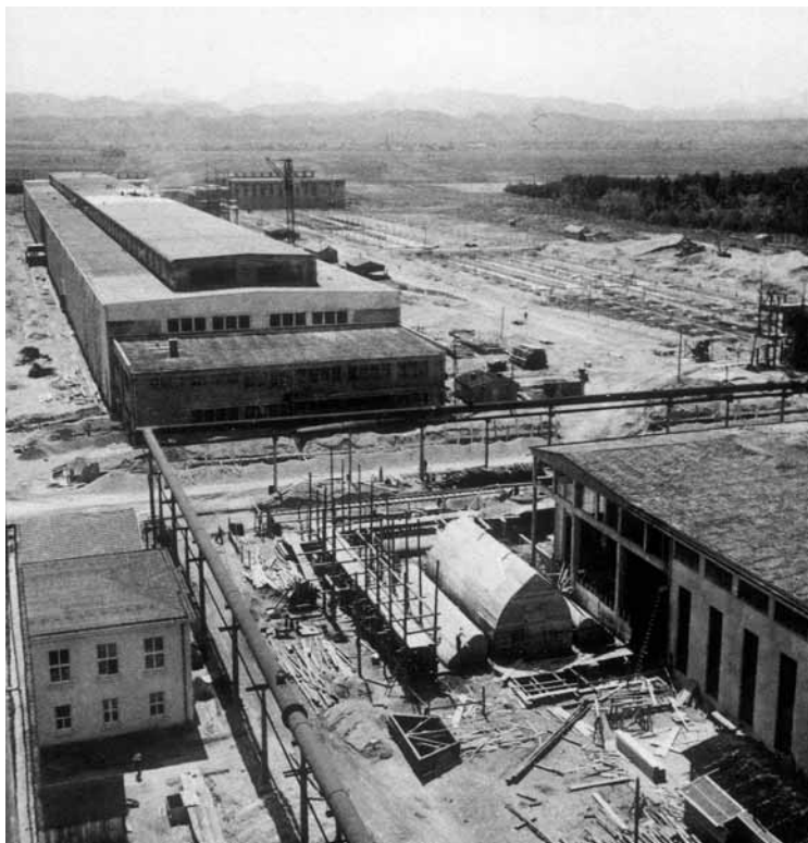
Gradbišče nove tovarne
