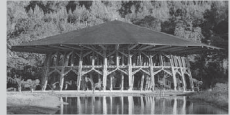
□ Slika 7. Paviljon, Expo 2000, Hannover, arh. Simon Velez. Leta 1999 je bil za V. svetovni kongres emisij v mestu Manizales v Kolumbiji zgrajen paviljon, ki je bil na pobudo švicarske neprofitne fundacije ZERI (Zero Emissions Research Initiative) razstavljen na Expo 2000 v Hannoveru. Po končani razstavi je postavljen nazaj v mesto Manizales. Vir: Dethier, 2002.
