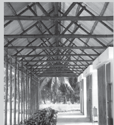
□ Slika 10. Bambus kot konstrukcijsko gradivo šole, Luong Son, Vietnam, arh. Theskyisbeautiful Architecture. Vir: Anon., 2004.
