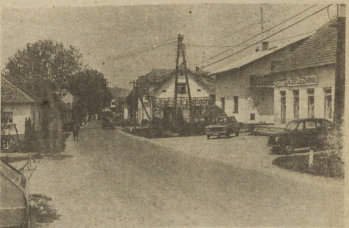
Skozi Rogoševce pelje asfaltna cesta in ob njej so razgibane domačije, pa tudi drugi objekti, kot je Železnina na sliki. Največ razmišljanj krajevnih odbornikov in ostalih občanov pa je namenjenih novi samopostrežbi.
