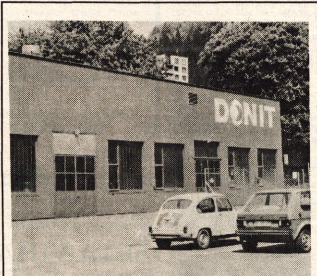
Jesenice, 10. maja - Minuli torek je DONIT iz Medvod slovensko odprl nov obrat v Podmežakli za proizvodnjo poliuretanskih filtrov. Objekt, ki je zgrajen na odkupljeni lokaciji tovarne Kovin Jesenice, ima 1.300 kvadratnih metrov površine in 600 kvadratnih metrov za pomožne dejavnosti. Predračunska vrednost investicije je bila 975.000 dinarjev. V novih prostorih so dosegli povečanje proizvodnih zmogljivosti za 30 odstotkov in boljše izkoriščenost materiala za 42 odstotkov. Proizvodnja filtrov ne bo onesnaževala okolja. - Foto: D. Sedej
