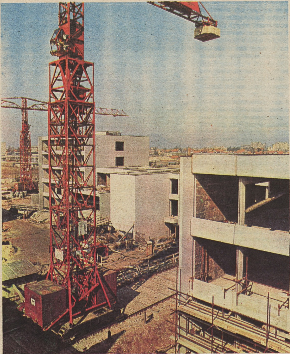
Na enem izmed sto Gradisovih gradbišč v Sloveniji – gradnja visokošolskega ekonomskega centra v Ljubljani. (Foto: A. Ul.)
