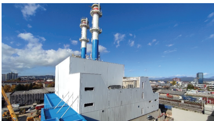
Slika 15. Glavni tehnološki objekt z jugovzhodne strani, september 2023.
