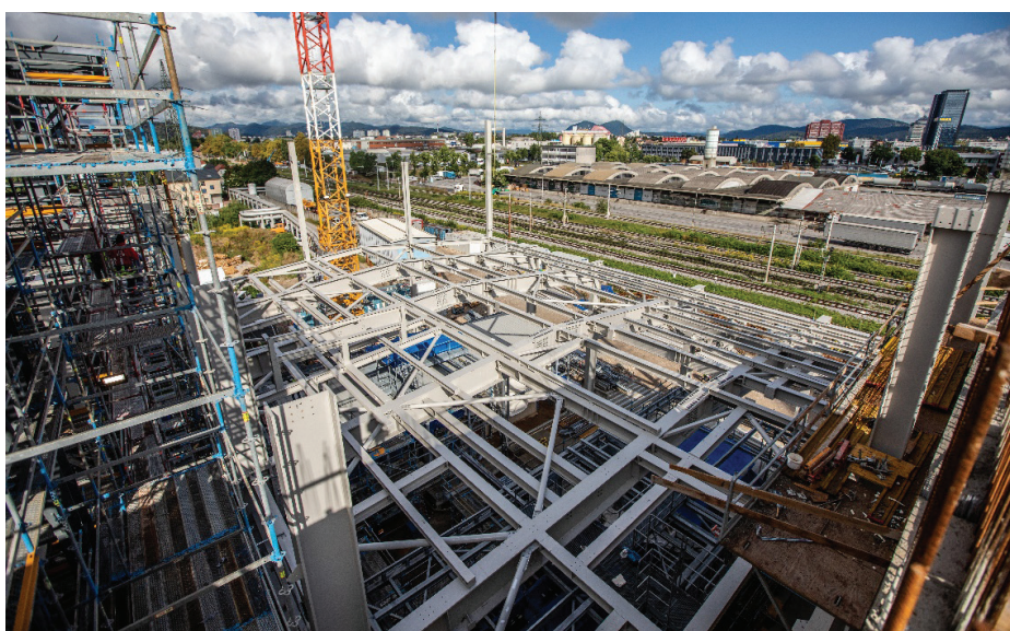
Slika 6. Jeklena konstrukcija zgradbe plinskih turbin, avgust 2021.
