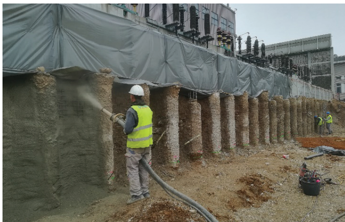
Slika 2. Gradbena jama s pilotno steno, oktober 2020.
