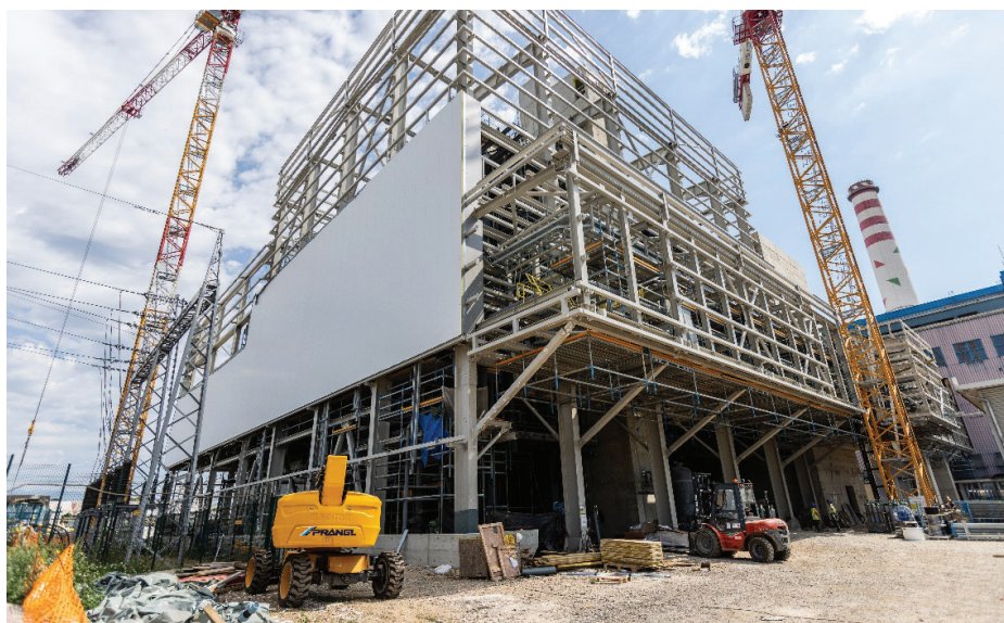
Slika 7. Pričetek izvedbe fasade, junij 2022.
