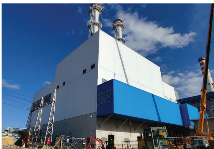
Slika 14. Glavni tehnološki objekt z jugozahodne strani, junij 2023.
