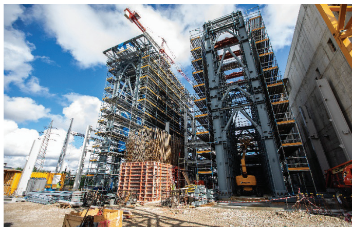
Slika 5. Jeklena konstrukcija kotlov (utilizatorjev), desno armiranobetonski elektroobjekt, avgust 2021.
