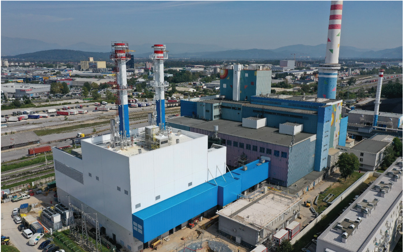
Slika 1. Posnetek nove plinsko-parne elektrarne iz zraka (Foto: Energetika Ljubljana).
