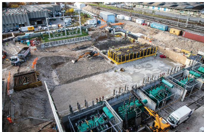
Slika 3. Gradbena jama, pričetek izvedbe turbinskih temeljev, november 2020.
