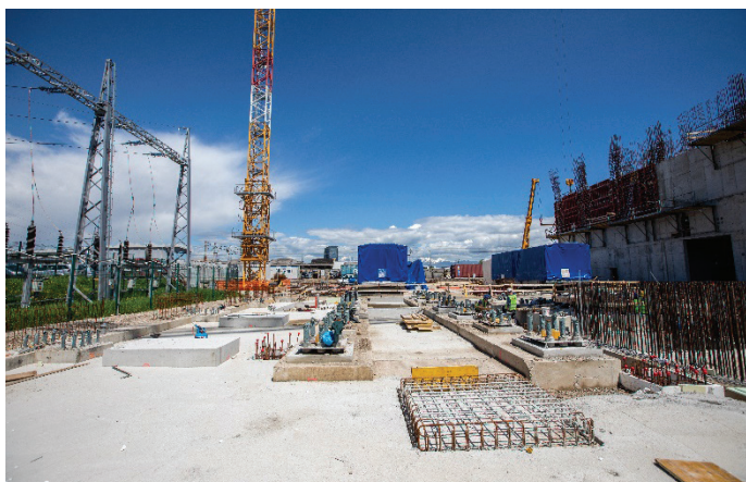
Slika 4. Na koti 0.00, na desni že raste elektroobjekt, maj 2021.
