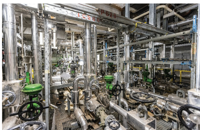
Slika 11. Polna notranjost tehnološkega objekta, avgust 2023.
