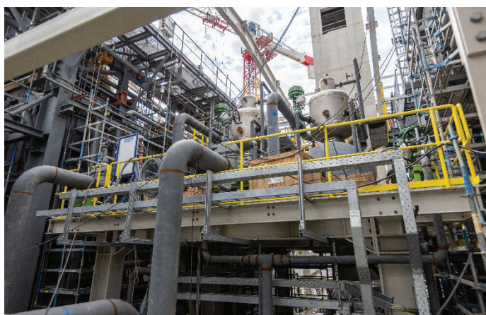
Slika 8. Zahtevna montaža cevodov in tehnološke opreme, junij 2022.
