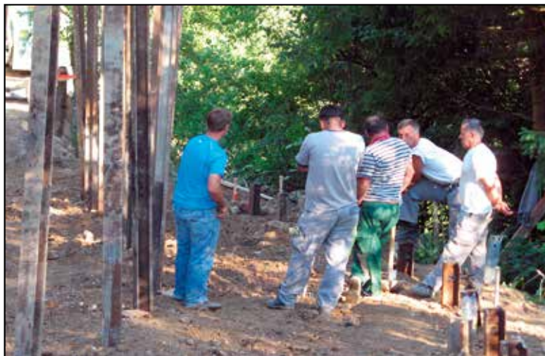
Temeljenje ovinka ceste s tirnicami, 5. 7. 2010.
