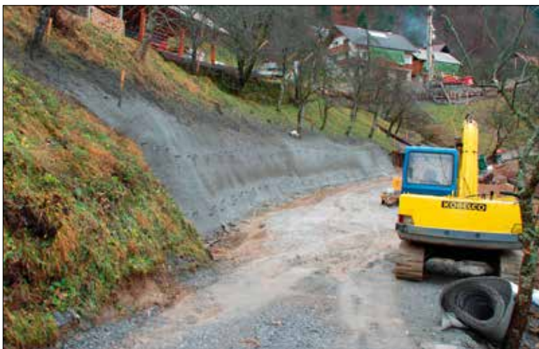
Priprave za vrtanje spodnje pilotne stene, 1. 12. 2009.
