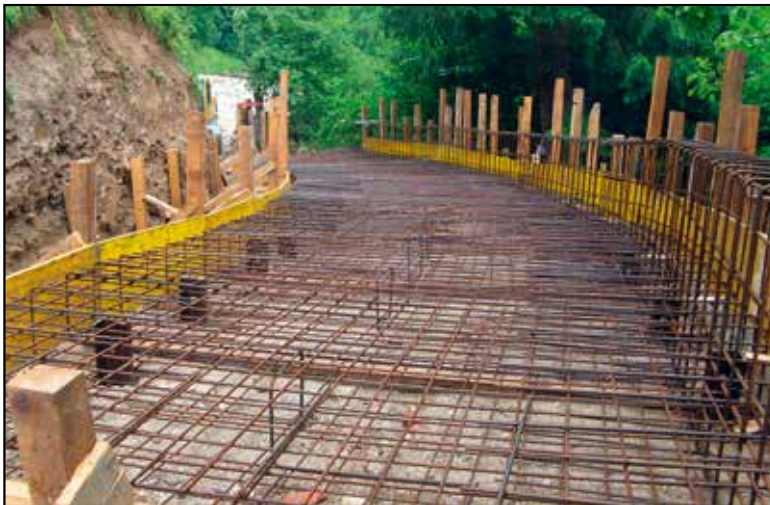
Ovinek ceste, pripravljen za betoniranje, 6. 7. 2010.
