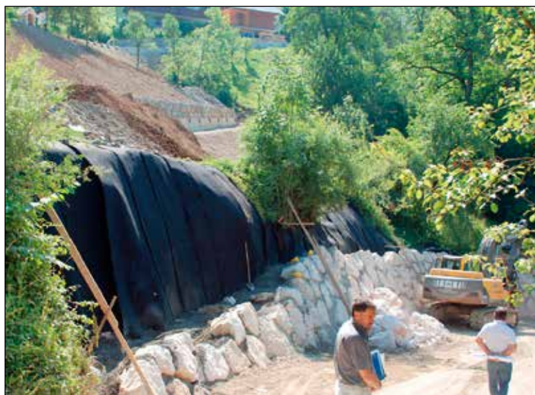
Izvedba kamnite zložbe v betonu na robu ceste, 1. 7. 2010.
