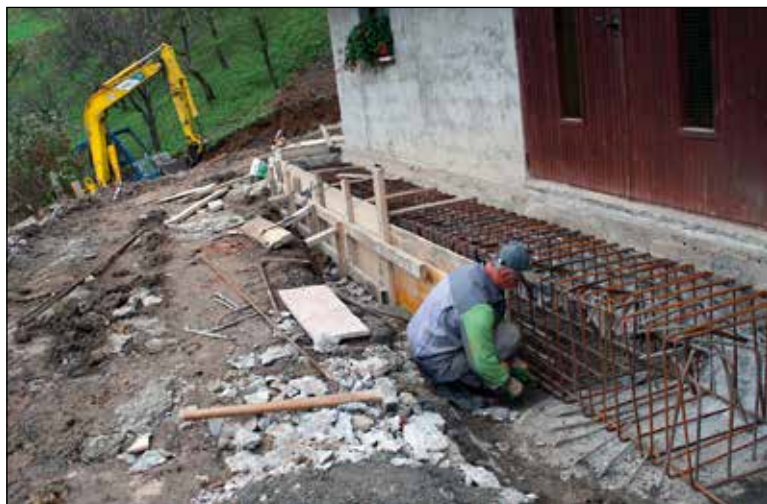
Povezava z gredo in stabilitetnimi vodnjaki, 19. 10. 2010.
