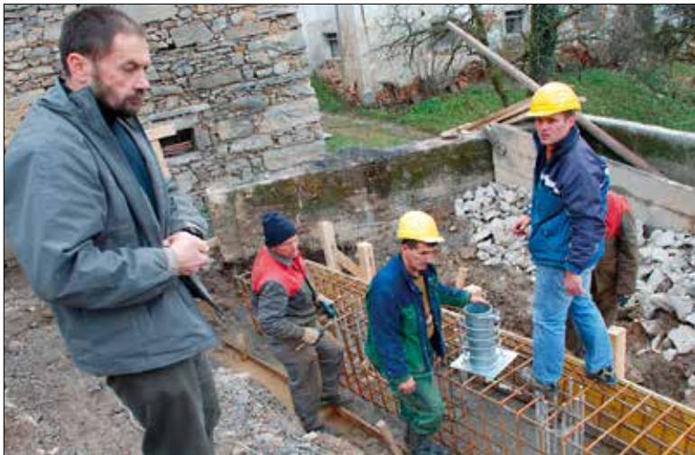
Izdelava AB-grede, ki povezuje pilote in sidra, 10. 12. 2009.
