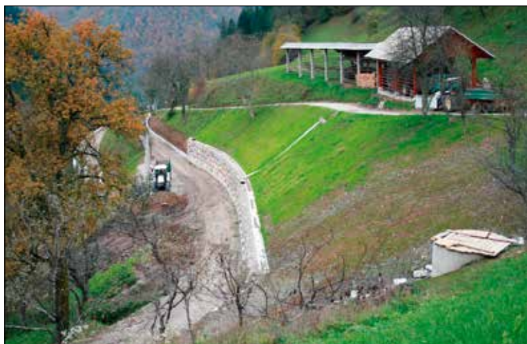
Po končani sanaciji plazu, 19. 10. 2010.
