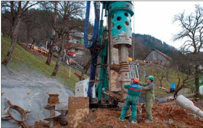
Vrtanje spodnje pilotne stene (pilot d = 0,80 m), 10. 12. 2009.
