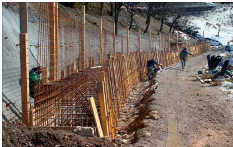
Izdelava AB-grede – spodnja pilotna stena, 16. 3. 2010.
