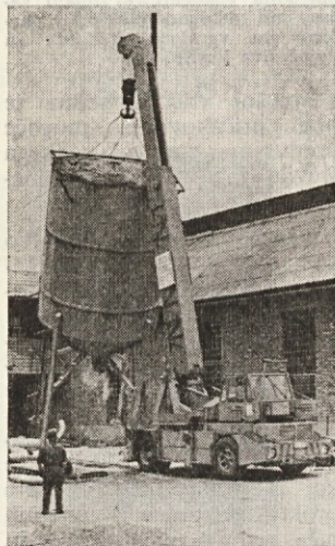
Demontaža silosa
