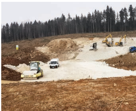
Ogled del v Poslovni coni Ločica, kjer potekajo zemeljska dela za zagotovitev ustreznega višinskega nivoja v prvem delu cone.
